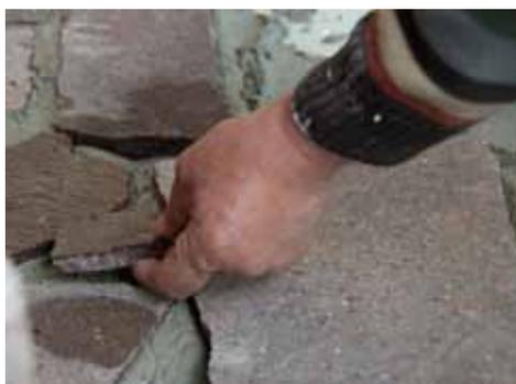
Una prima mano dal lato liscio della spatola e successivamente una mano con il lato dentato della spatola. Nel caso di piastrelle di grandi dimensioni, pavimenti da levigare e carichi gravosi in genere, per una maggiore sicurezza nell'applicazione consigliamo di spalmare il materiale anche sul retro della piastrella.
