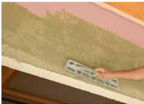
Prima di applicare l'intonaco di fondo, impregnare con un primer del tipo ISOLFIX, diluito in acqua in rapporto 1:1 o effettuare un rinzafo con malta cementizia magra e grossolana additivata con EMULSIONMIX in rapporto 1:5 con l'acqua d'impasto.
