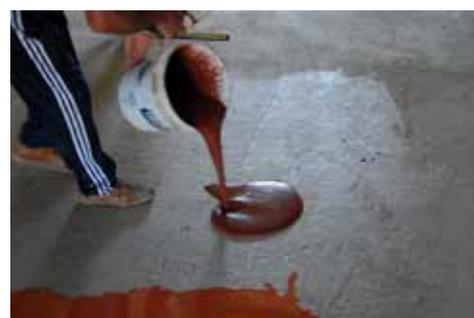
1. Applicazione di una mano di PAVIMIX 60 COLOR mediante asta gommata
